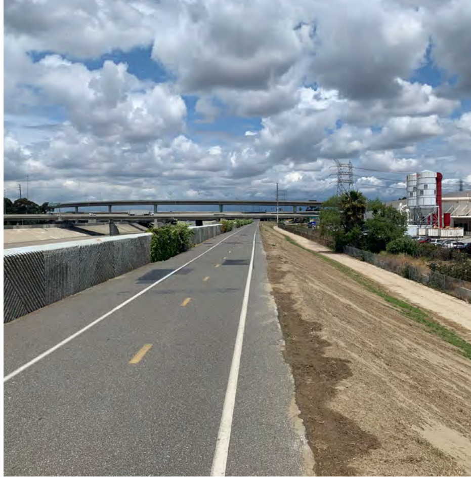
Figura 62. Las paredes del parapeto del río inferior, como las que se muestran en la milla del río 10.1, se instalaron a finales de los años 1990 con el fin de aumentar la capacidad del canal a más del evento del 1%. Fuente: OLIN, 2019.
