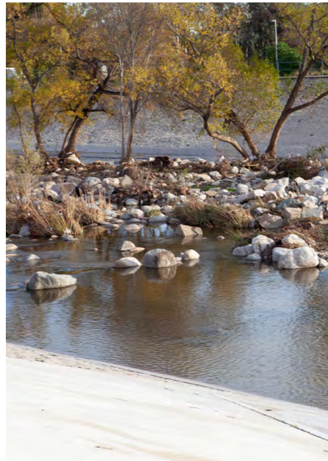
Figura 61. El sedimento y la vegetación invasora en los fondos blandos, como esta área en la milla del río 31.2 cerca de Glendale, inhibe los flujos y aumenta el riesgo de inundación. Fuente: OLIN, 2018.
