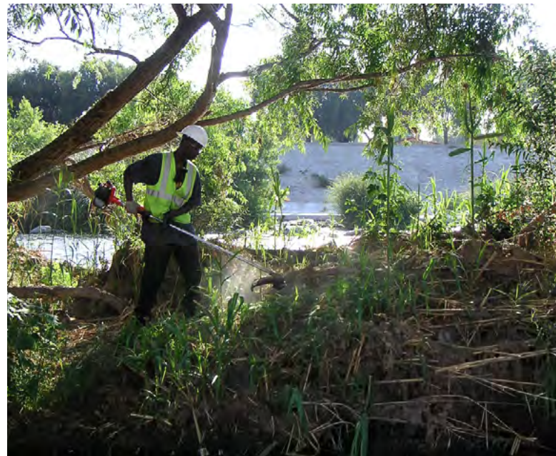
Figura 153. Un trabajador elimina el material vegetal invasor del canal cerca de Glendale Narrows, una práctica de mantenimiento que ayuda a aumentar la capacidad de inundación del Río de Los Ángeles. Fuente: US Army Corps of Engineers, LA River Arundo Removal, 2004.
