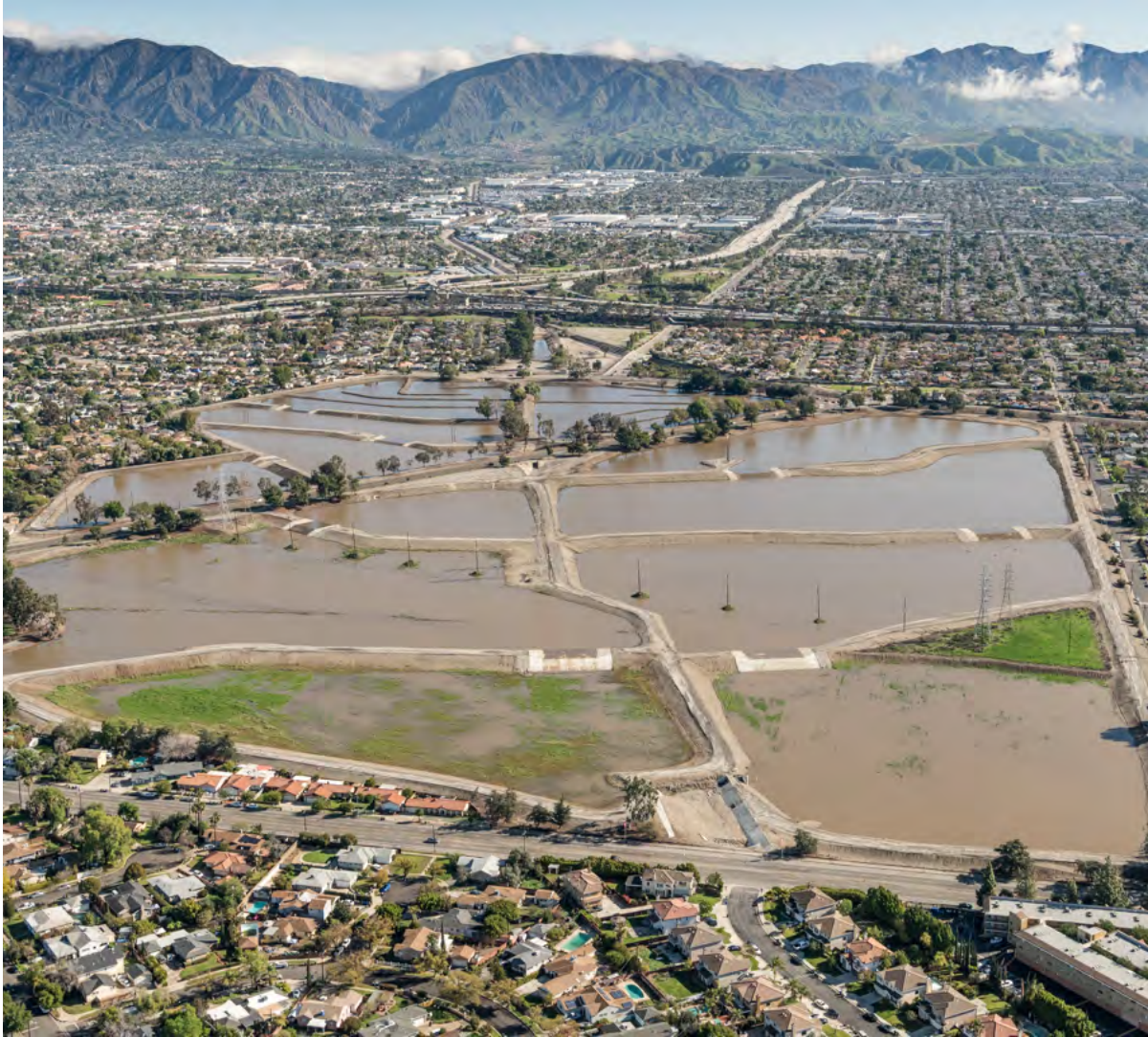
Figura 71. Nuestras cuencas de aguas subterráneas locales se recargan utilizando diferentes técnicas, como la difusión de terrenos como este en Pacoima. Fuente: LA County Public Works, 2018.
