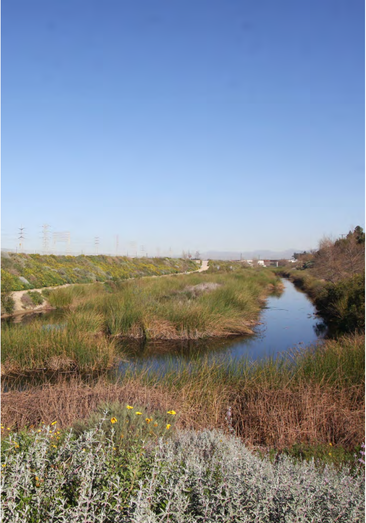
Figura 24. Vista hacia el norte a través de los humedales de Dominguez Gap, uno de los proyectos de demostración del Plan Maestro del Río de Los Ángeles de 1996 en la milla del río 4.9. Fuente: OLIN, 2018.
